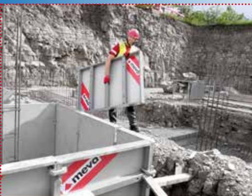
MEVA AluFix ist eine leichte Handschalung aus Aluminium, die hohe Flexibilität beim Schalen von Betonwänden und sogar -Decken bietet. Der kranfreie Einsatz und das geschlossene Aluminiumprofil machen MEVA AluFix zu einem vielseitigen modularen System, das jederzeit hochwertige Betonergebnisse liefert.
